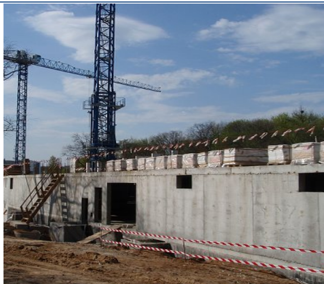
Стан будівництва житлового комплексу по вул. Фронтівій, 3 у м. Харкові станом на 02.08.2009 р.
