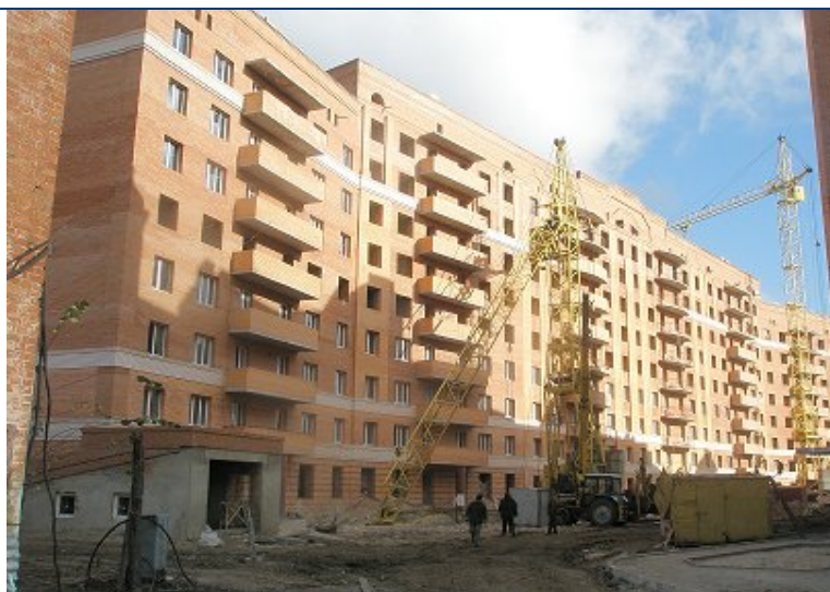
Житловий будинок по вул. Жовтневій, 40-Д у м. Полтаві, станом на 02.11.2009 р.
