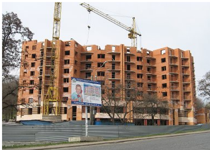
Житловий будинок по вул. Леніна, 74 у м. Полтаві, станом на 20.04.2010 р.
