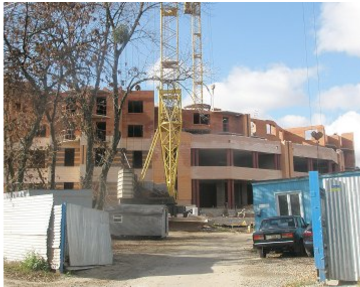
Житловий будинок по вул. Леніна, 74 у м. Полтаві, станом на 02.11.2009 р.
