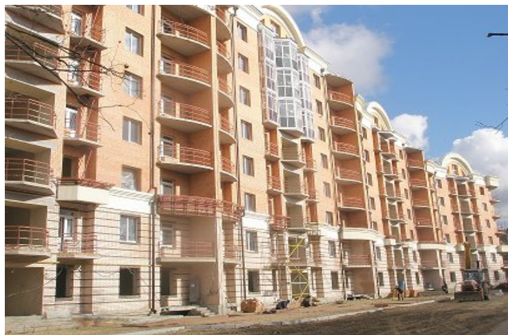
Житловий будинок по вул. Жовтневій, 40-В у м. Полтаві, станом на 02.11.2009 р.
