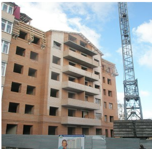
Житловий будинок по вул. Паризької комуни, 20 у м. Полтаві, станом на 02.11.2009 р.
