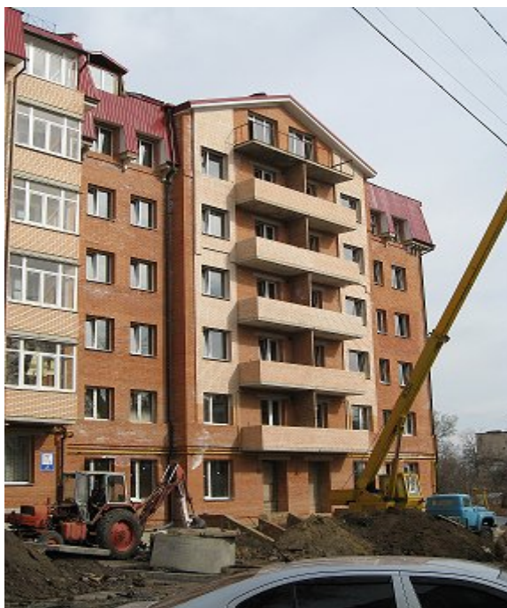
Житловий будинок по вул. Паризької комуни, 20 у м. Полтаві, станом на 20.04.2010 р.
