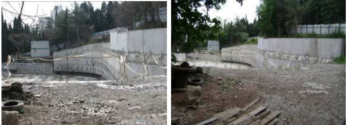
Стан будівництва за проектом реконструкції кінотеатру з добудовою рекреаційно-оздоровчого корпусу за адресою: АР Крим, смт. Гурзуф, вул. Ленінградська, 1 А станом на лютий 2009 року та початок червня 2009 року
