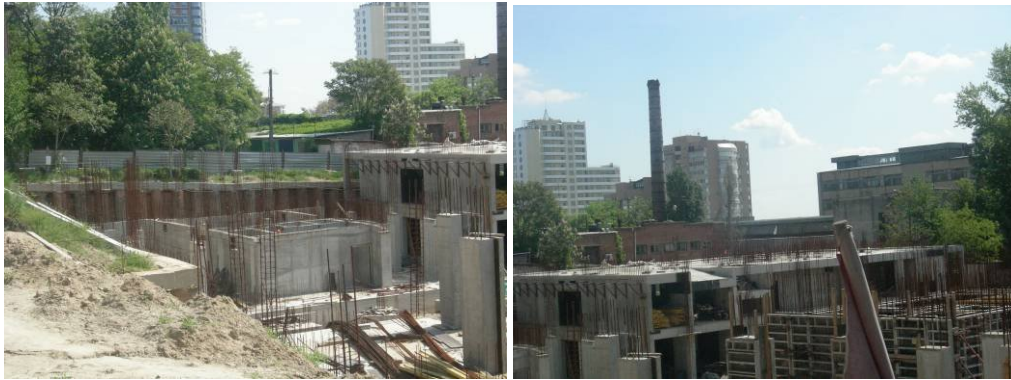
Рисунок 1. Будівництво житлового будинку по вул. Фурманова, 11 у м. Дніпропетровськ станом на середину червня 2009 року
