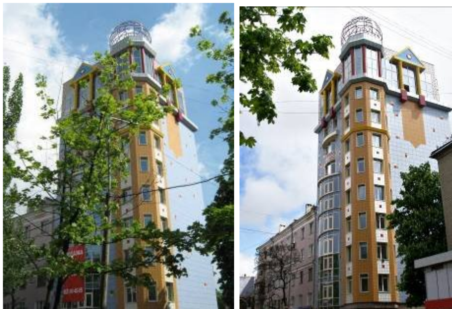
Житловий будинок по вул. Артема, 90 в у м. Донецьку станом на 29.05.2009 р. та станом на вересень 2009 р.
