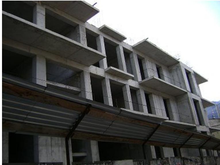
Хід робіт на об'єкті будівництва по вул. Ігнатенко, 9 у м. Ялті станом на 09.03.2011 р.
