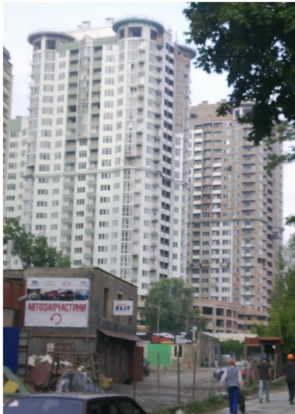
Рисунок 1. Будівельні роботи на об'єкті будівництва житлового комплексу по вул. Механізаторів, 2 (ж/к «Ізумрудний») у Солом'янському районі м. Києва станом на червень 2010 р.
