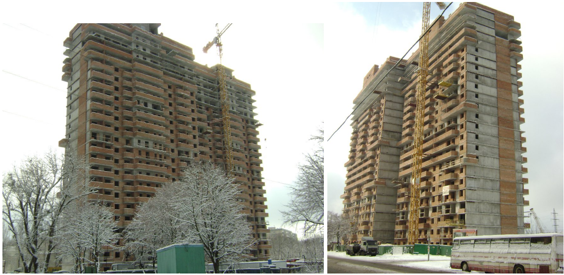
Будівельні роботи на об'єкті будівництва в м. Києві по вул. Генерала Наумова, 66 станом на 01.02.2009 р.
