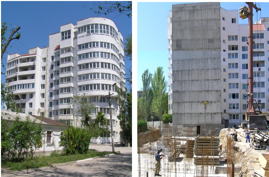
Рисунок 2. Будівельні роботи по вул. Вересаєва, 12 у м. Феодосії станом на травень 2010 року
