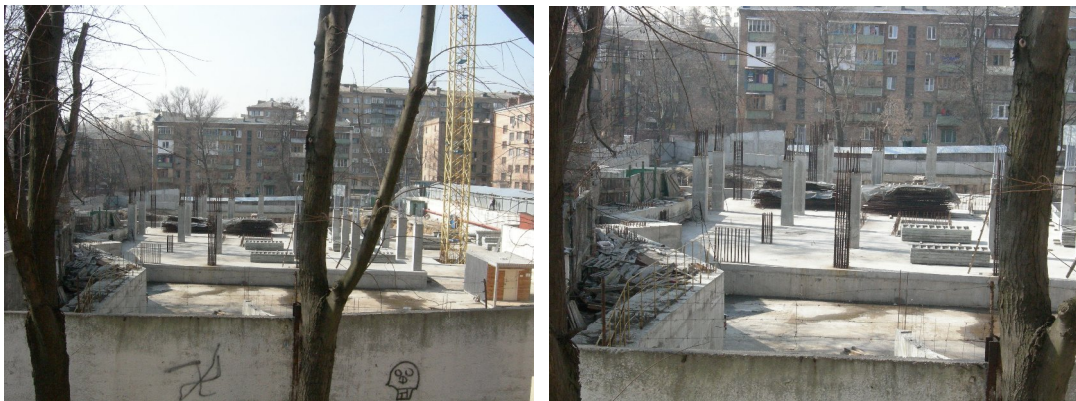
Хід робіт з будівництва багатоповерхового житлового будинку з вбудовано-прибудованими приміщеннями громадського призначення та підземного паркінгу по вул. Білоруській, 36-а у Шевченківському районі м. Києва станом на березень 2010 року
