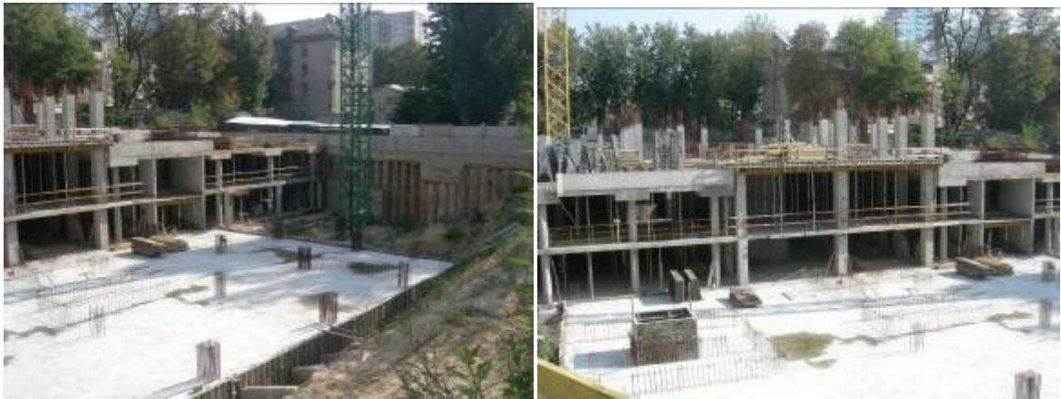
Хід робіт з будівництва багатоповерхового житлового будинку з вбудовано-прибудованими приміщеннями громадського призначення та підземного паркінгу по вул. Білоруській, 36-а у Шевченківському районі м. Києва станом на вересень 2009 року
