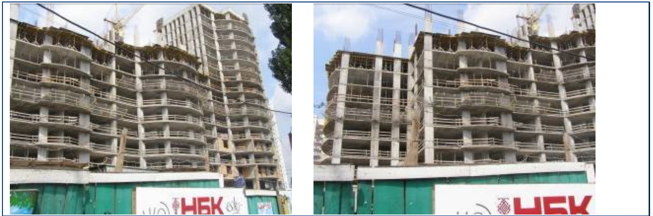
Будівельні роботи на секціях 1-3 житлового будинку № 26 станом на кінець серпня 2009 року
