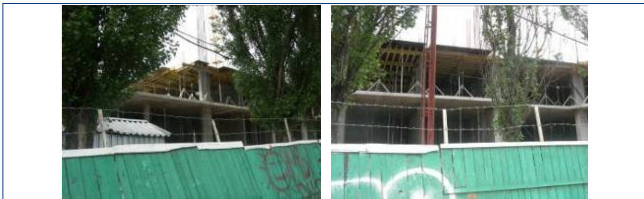
Будівельні роботи на секціях 1-4 житлового будинку № 28 станом на середину травня 2009 року
