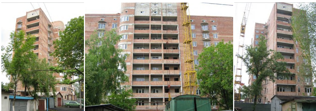
Рисунок 1.3. Стан будівництва житлового будинку по вул. Бакинських Комісарів, 100 у м. Донецьку станом на 29.05.2009 р.
