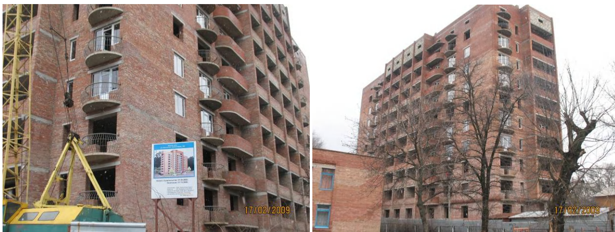
Рисунок 1.2. Стан будівництва житлового будинку по вул. Бакинських Комісарів, 100 у м. Донецьку станом на 17.02.2009 р.
