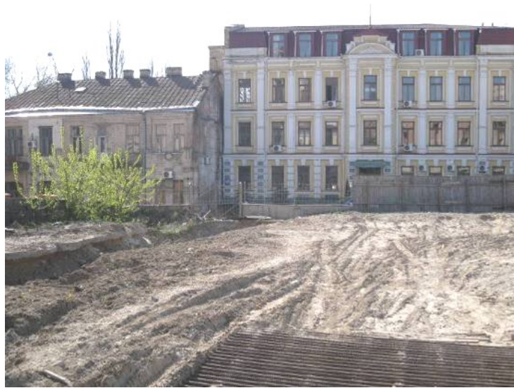
Хід робіт на об'єкті будівництва по вул. Воровського, 21 у м. Києві станом на 23.04.2009 р.
