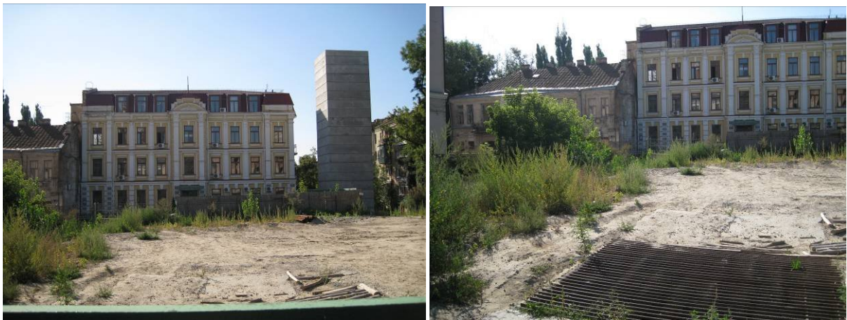
Хід робіт на об'єкті будівництва по вул. Воровського, 21 у м. Києві станом на 26.08.2009 р.
