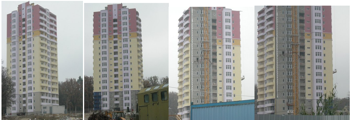
Стан будівництва житлового комплексу Grand Life в м. Ірпені Київської області станом на 05.11.2009 р.
