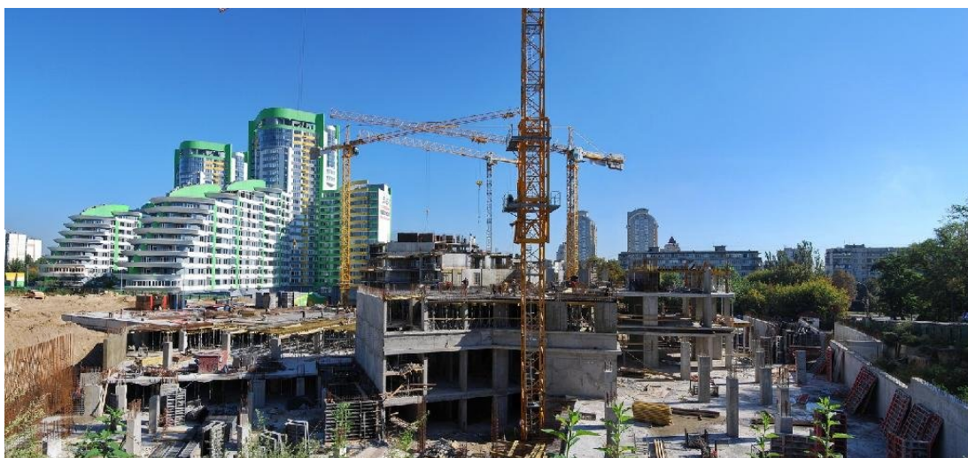
Стан будівництва II черги житлового комплексу по вул. Вишгородській, 45 у м. Києві у липні та вересні 2010 року (зверху вниз)
