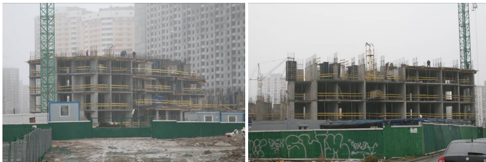
Рисунок 1.2. Будівництво житлового будинку з вбудованими приміщеннями громадського обслуговування, торгівлі, підземним паркінгом, гостювою автостоянкою по вул. Олени Пчілки у 4-му м/н ж/м Позняки у Дарницькому районі м. Києва станом на середину лютого 2009 року
