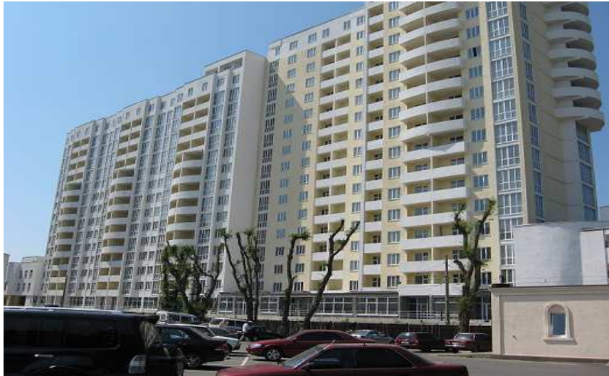
Житловий будинок по вул. Ак. Корольова, 5/2 у м. Одесі
