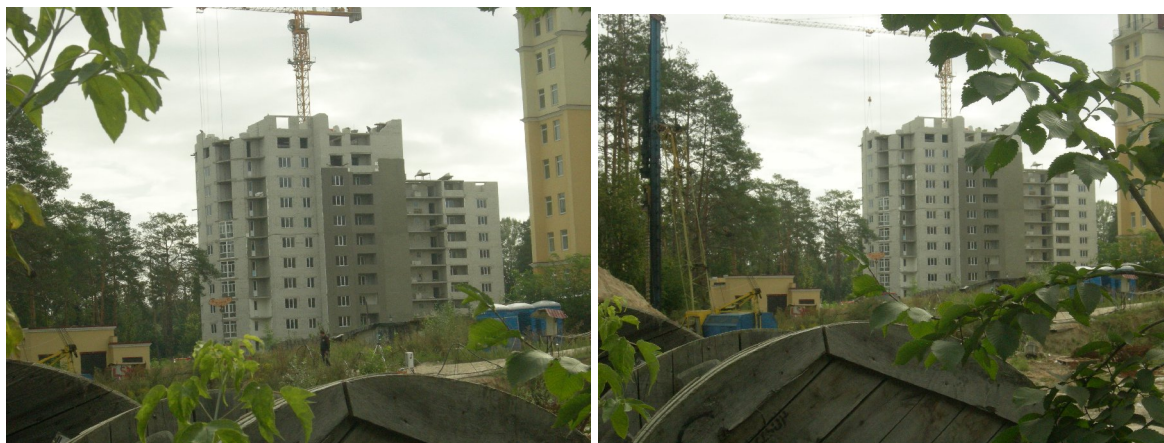
Будівництво житлового комплексу (II черга) в Київській області с. Чайки по вул. Лобановського, 1 станом на вересень 2010 р.
