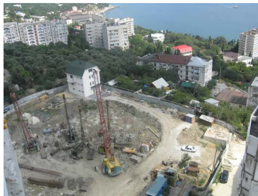
Рисунок Ошибка! Текст указанного стиля в документе отсутствует..4. Стан робіт на об'єкті будівництва по вул. Южній, 64-66 (II черга), станом на кінець березня 2009 року
