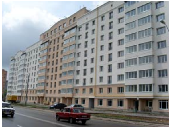
Житловий будинок по вул. Білогорській, 17-21 у м. Боярці станом на 05.06.2009 р.
