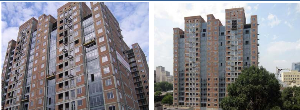
Хід робіт на об'єкті будівництва по пров. Ламаному в м. Дніпропетровську станом на 30.07.2011 р.
