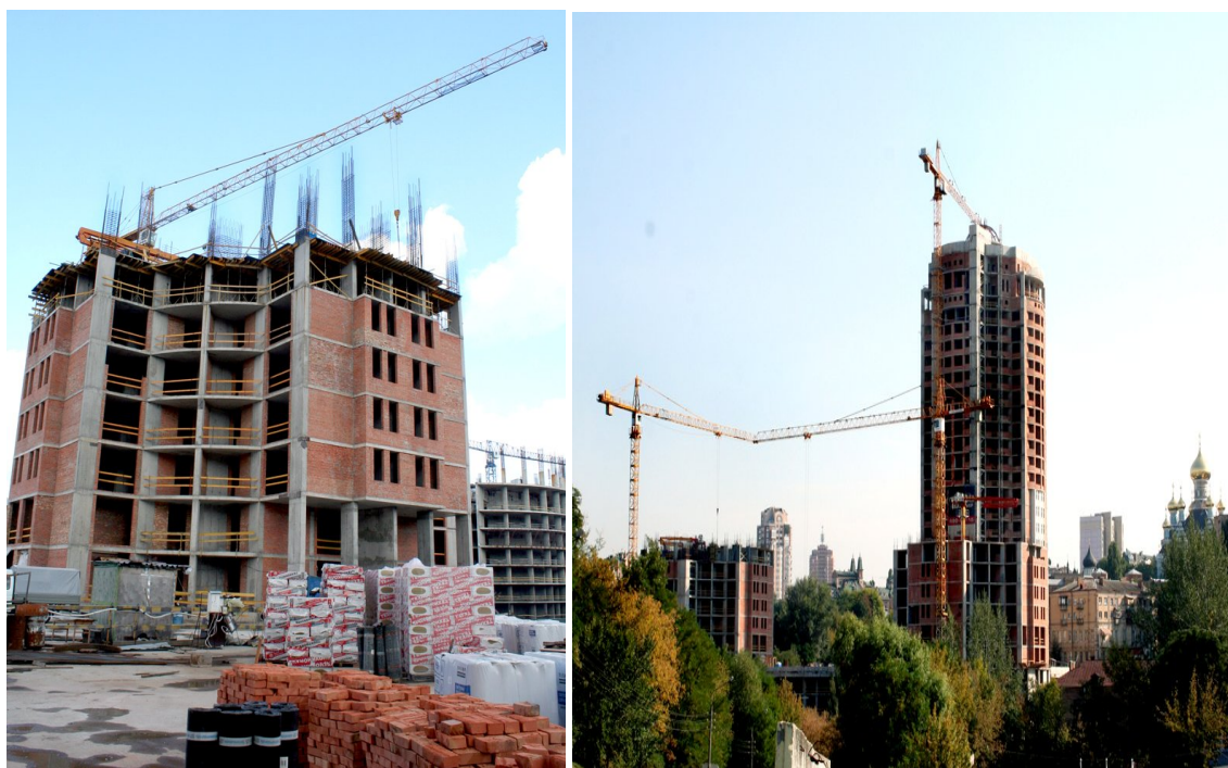
Рисунок 1. Будівельні роботи на об'єкті будівництва офісно-житлового комплексу в м. Києві на ділянці, обмеженої вулицями Глибочицькою, Студентською та Пимоненка станом на кінець вересня 2011 року
