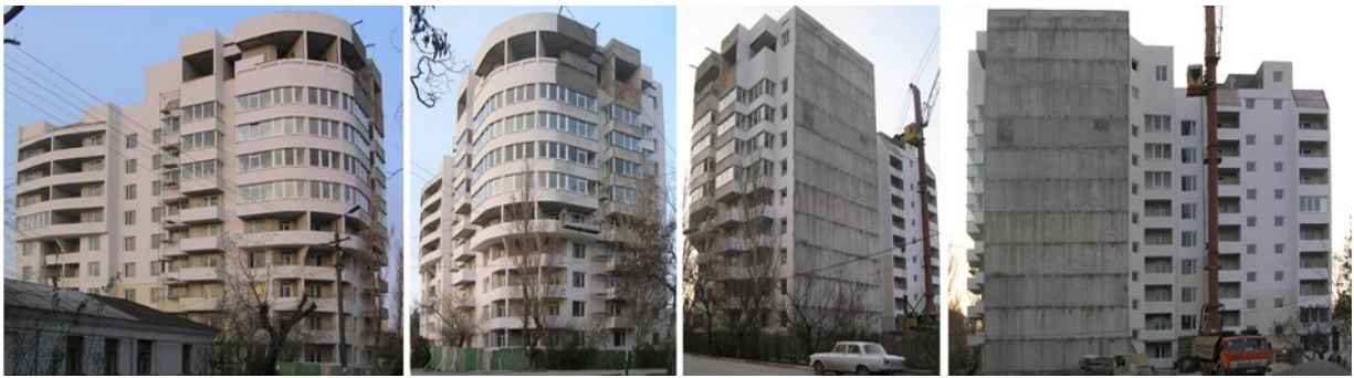
Рисунок 2. Будівельні роботи по вул. Вересаєва, 12 у м. Феодосії станом на грудень 2009 року
