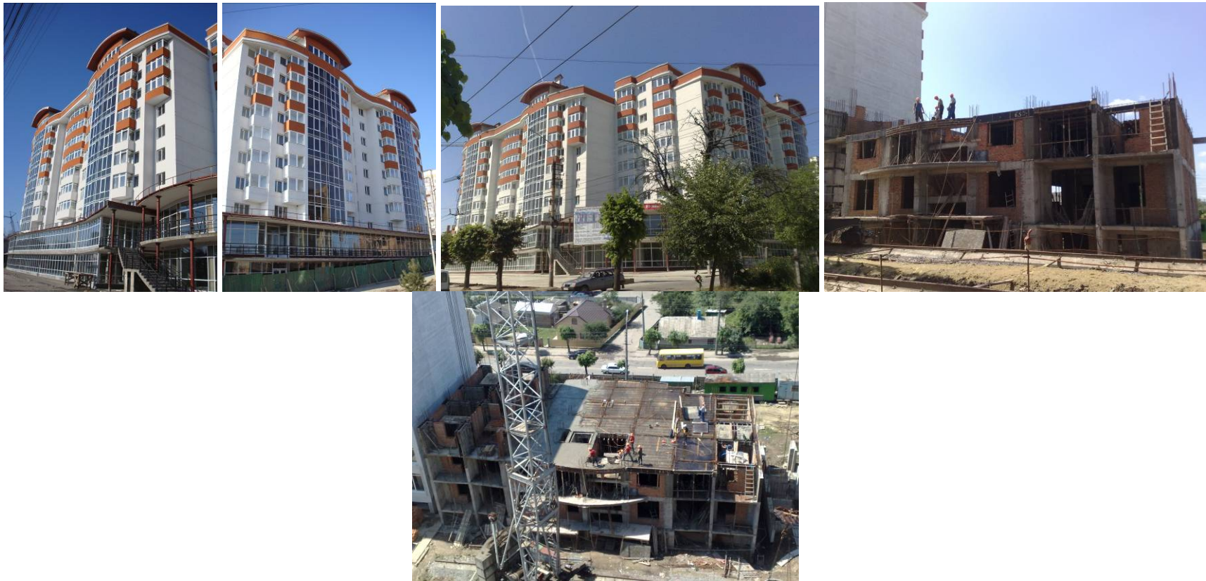
Рисунок 2.2. Будівництво житлового комплексу у м. Чернівцях по вул. Руській, 219 (будинки №№ 5 та 6 - зверху, будинок №4 - знизу) станом на середину травня 2009 року
