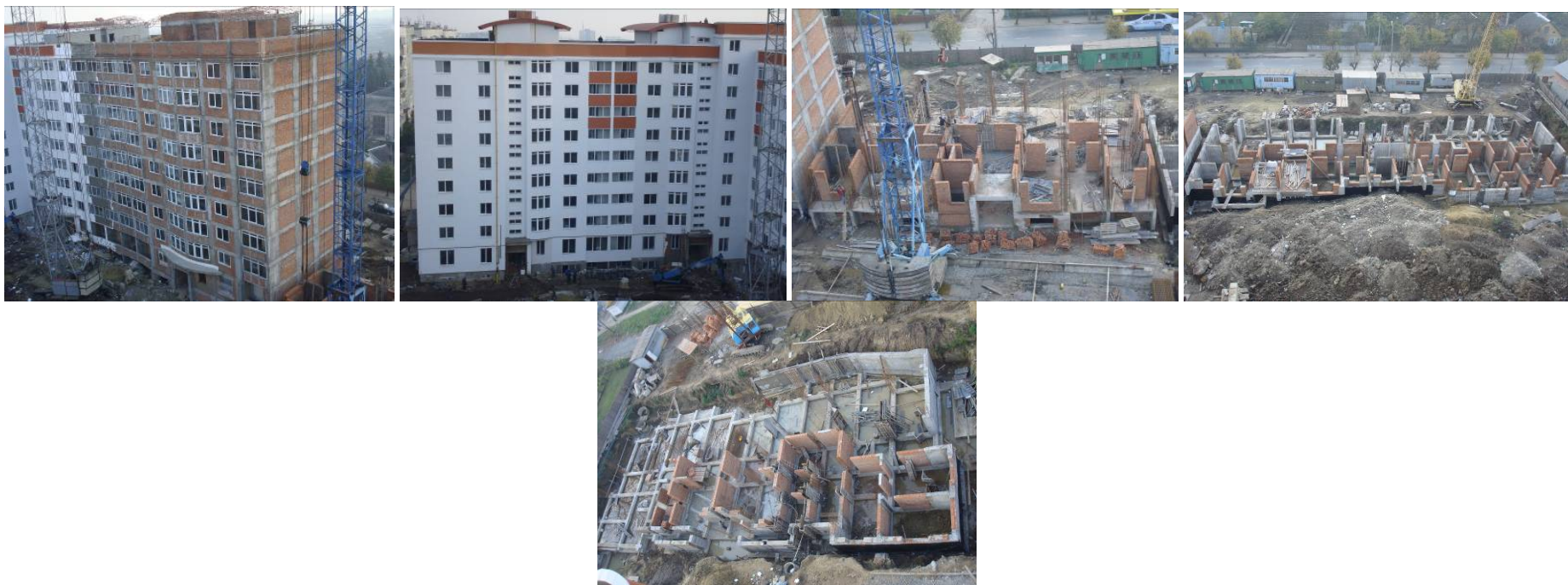
Рисунок 2.1. Будівництво житлового комплексу у м. Чернівцях по вул. Руській, 219 (зверху зліва-направо будинки №№ 5, 6 та 4; знизу зліва-направо фундаменти будинків №№ 3 та 2) станом на кінець 2008 року
