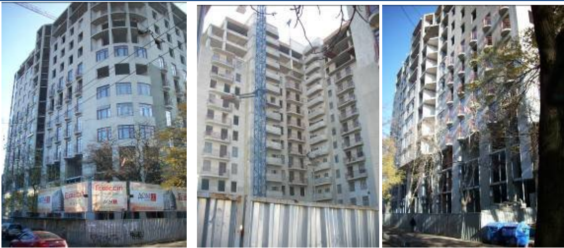
Хід будівництва житлово-торговельного комплексу по вул. Грецькій, 1 у м. Одесі станом на кінець листопада 2009 р.
