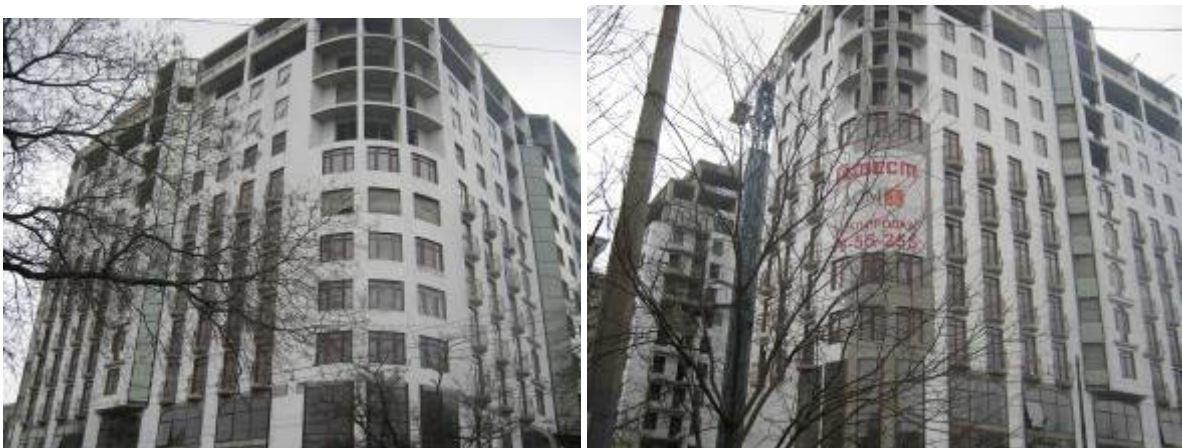
Хід будівництва житлово-торговельного комплексу по вул. Грецькій, 1 у м. Одесі станом на початок квітня 2010 р.
