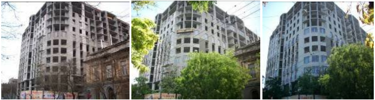
Хід будівництва житлово-торговельного комплексу по вул. Грецькій, 1 у м. Одесі станом (зліва-направо) на 20.02.2009 р., на 29.05.2009 р. та станом 08.09.2009 р.
