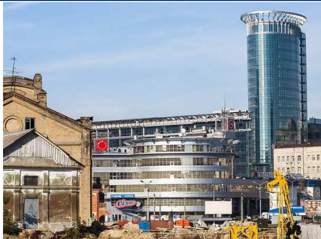
Об'єкт незавершеного будівництва по вул. Мельникова, 2/10, станом на початок 2016 року (протягом 2015 року без змін)
