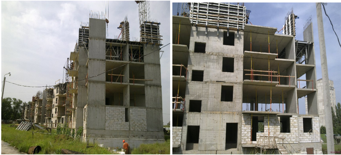
Рисунок Ошибка! Текст указанного стиля в документе отсутствует.. Житловий будинок по вул. Зубарева, 7 у м. Харкові станом на 01.07.2011 р.
