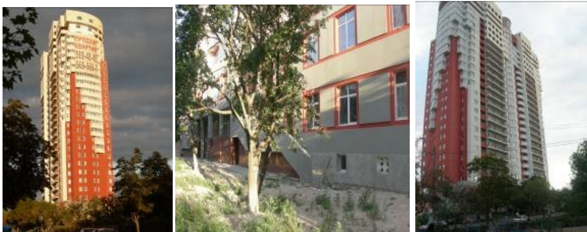
Об'єкт будівництва по вул. П. Запорожця, 26-А станом на вересень 2009 року
