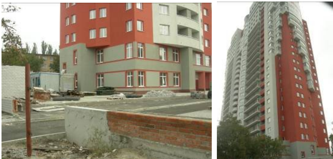
Об'єкт будівництва по вул. П. Запорожця, 26-А станом на серпень 2010 року
