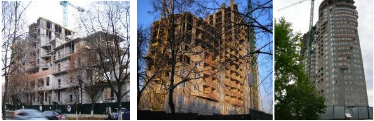
Хід робіт на об'єкті будівництва по вул. П. Запорожця, 26-А станом на (зліва - направо) початок листопада 2007 року, початок лютого 2008 року, початок травня 2008 року
