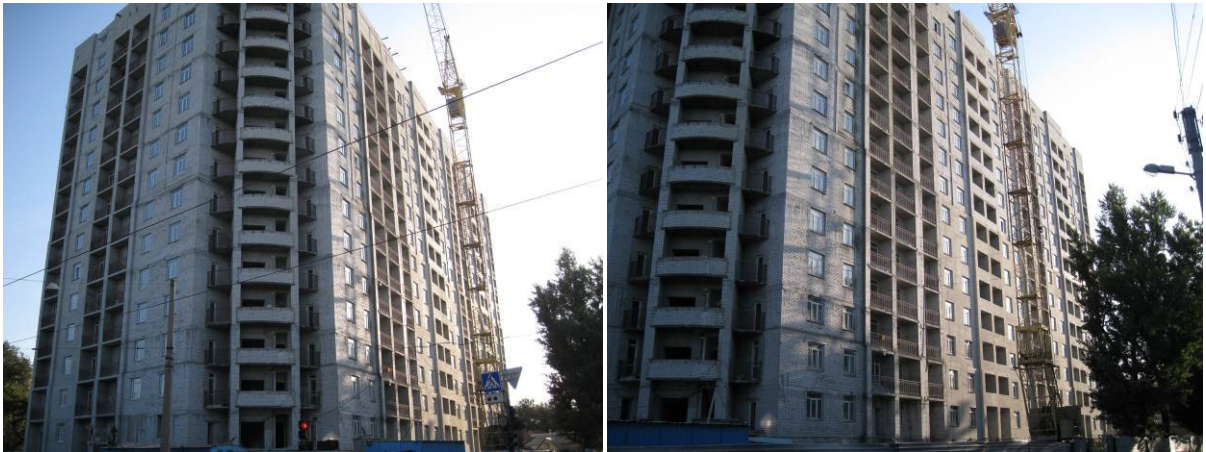
Хід робіт на об'єкті будівництва по вул. Греківській, 3 у м. Харкові станом на 21.08.2009 р.
