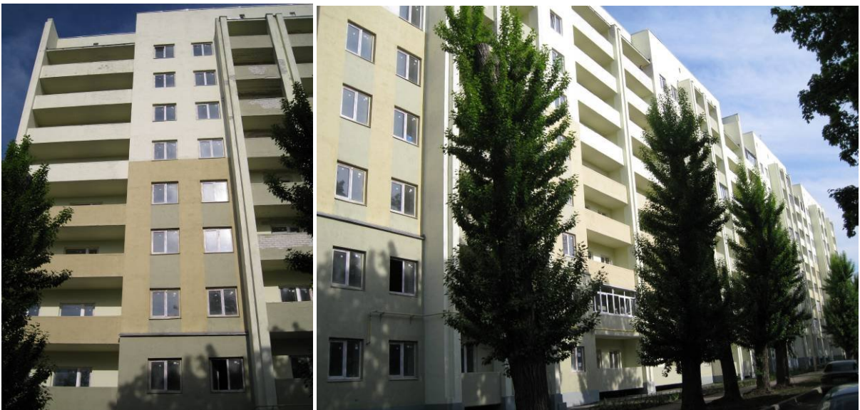
Хід робіт на об'єкті будівництва (секції Є) по Салтівському шосе, 73 у м. Харкові в м. Харкові
