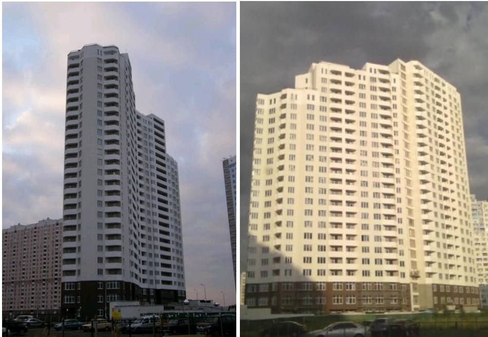
Рисунок 1. Об'єкт будівництва житлового будинку по вул. О. Пчілки у 4-му м/н ж/м Позняки
