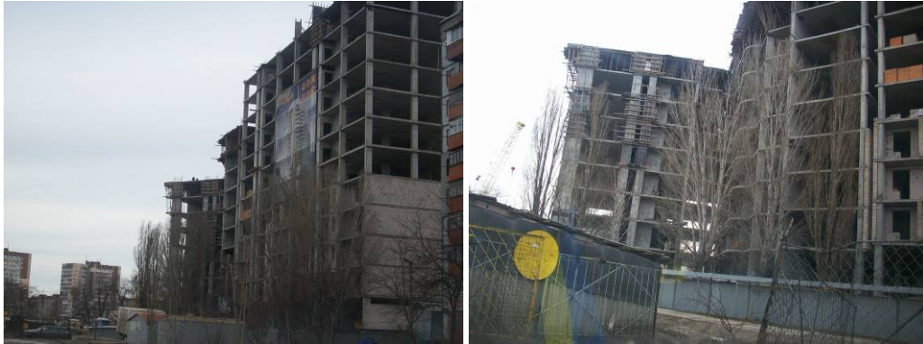
Рисунок 1. Будівництво житлового будинку по вул. Ак. Корольова, 5/2 у м. Одесі станом на середину лютого 2009 року
