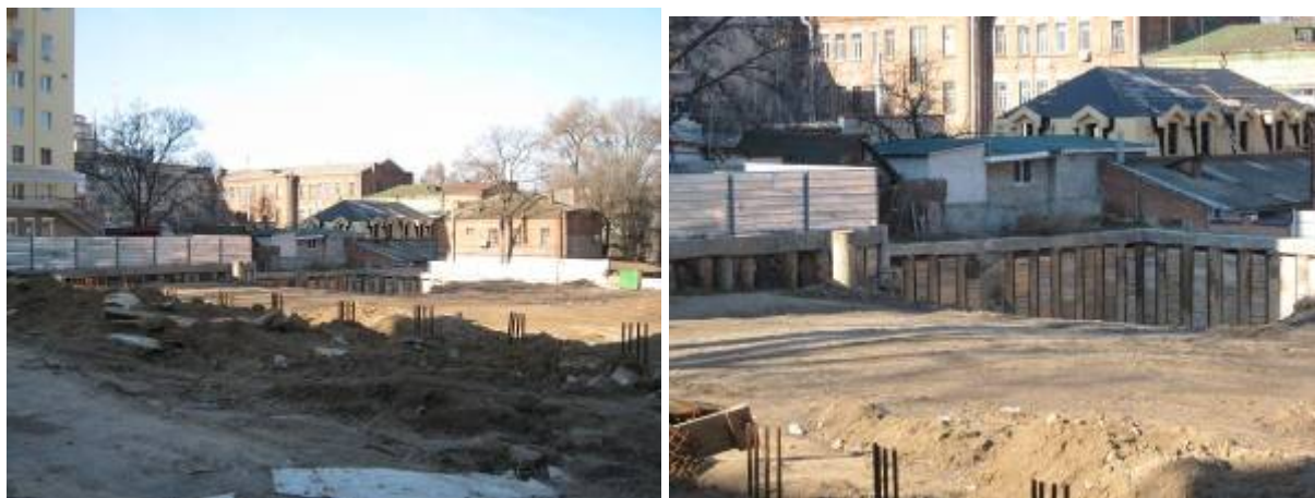
Хід робіт на об'єкті будівництва по вул. Шевченка у м. Дніпропетровську в 2009 році
