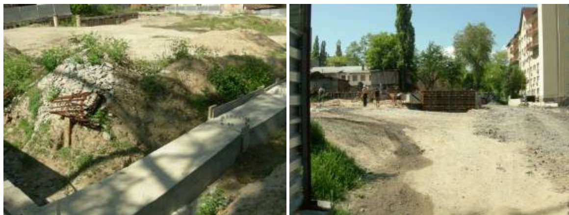
Хід робіт на об'єкті будівництва по вул. Шевченка у м. Дніпропетровську в 2010 році
