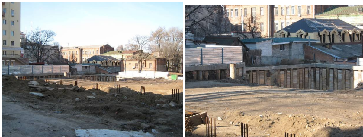
Хід робіт на об'єкті будівництва по вул. Шевченка у м. Дніпропетровську
