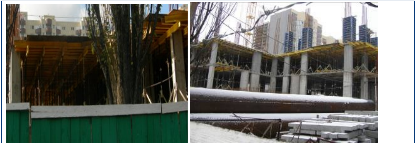
Рисунок 1.5. Будівельні роботи на секціях 1-4 житлового будинку № 28 станом кінець вересня 2008 року та на середину лютого 2009 року
