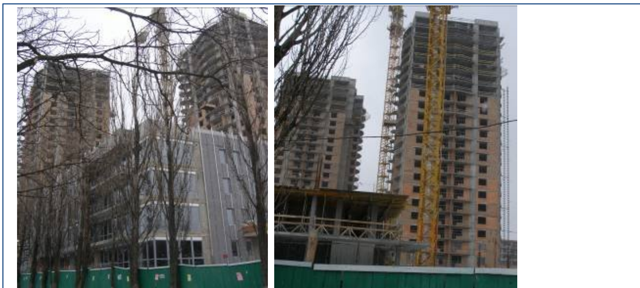
Рисунок 1.10. Будівельні роботи по житловим будинкам №№ 33 та 34 та адміністративному будинку № 36 станом на середину лютого 2009 року
