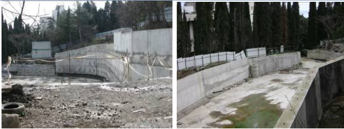
Стан будівництва за проектом реконструкції кінотеатру з добудовою рекреаційно-оздоровчого корпусу за адресою: АР Крим, смт. Гурзуф, вул. Ленінградська, 1 А станом на лютий 2009 року та на початок березня 2010 року
