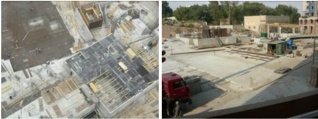
Хід будівництва житлового комплексу «Парк Авеню» (II- IX черги) станом на 20.05.2009 р. та станом на 15.09.2009 р.
