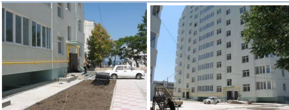
Рисунок 1.3. Стан будівництва 2-х житлових будинків по вул. Рєпіна, 19 у м. Севастополі станом на кінець липня 2009 р.
