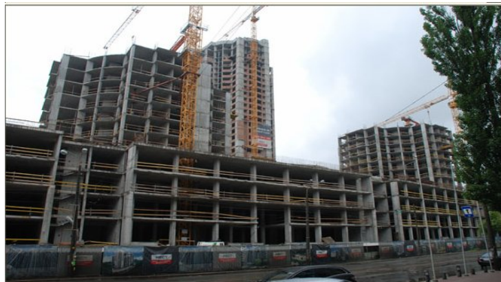
Рисунок 1.2. Будівельні роботи на об'єкті будівництва офісно-житлового комплексу в м. Києві на ділянці, обмеженої вулицями Глибочицькою, Студентською та Пимоненка станом на 01.06.2009 р.
