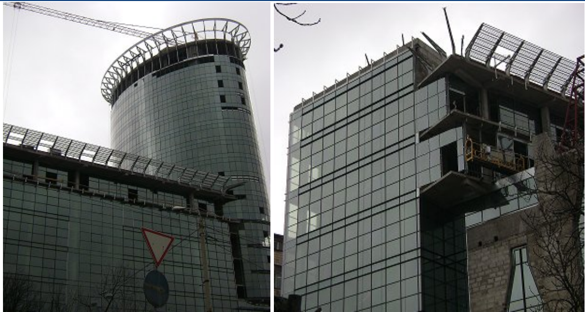
Хід робіт на об'єкті будівництва по вул. Мельникова, 2/10, станом на 19.03.2009 р.
