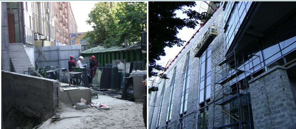
Хід робіт на об'єкті будівництва по вул. Мельникова, 2/10, станом на 18.06.2009 р.
