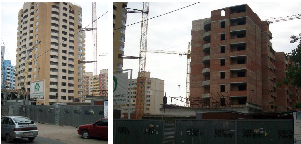
Рисунок 1.2. Стан будівництва громадсько-житлового комплексу по вул. М. Говорова, 10 А у м. Одесі на кінець травня 2009 року
