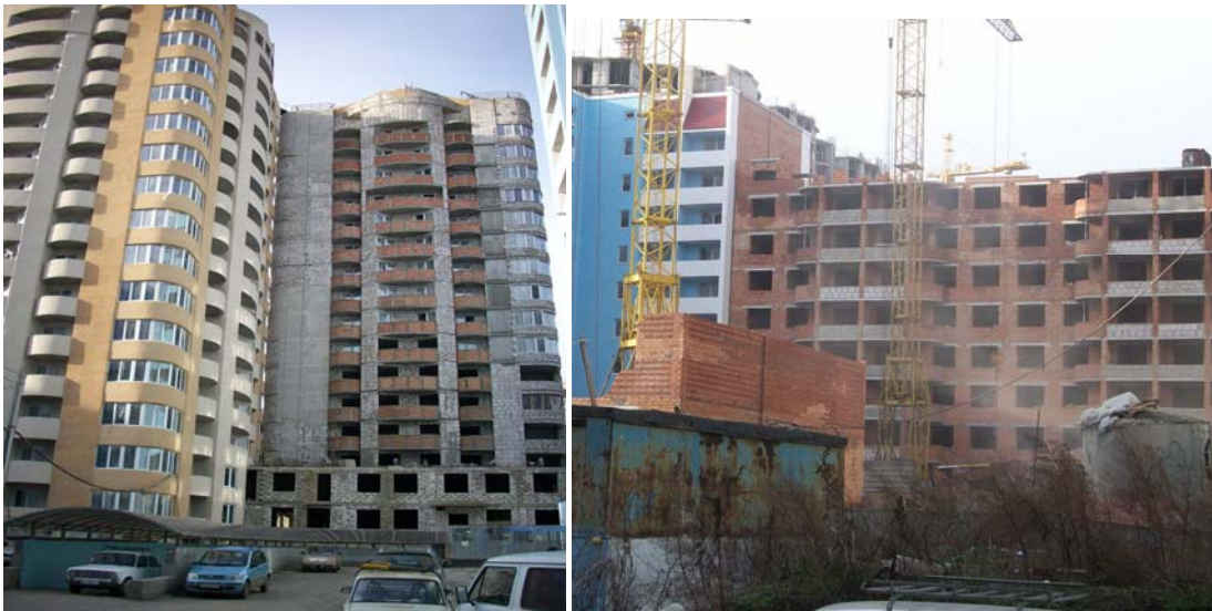
Рисунок 1.1. Стан будівництва громадсько-житлового комплексу по вул. М. Говорова, 10 А у м. Одесі на 23.03.2009 р.
