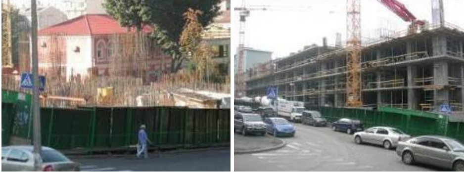
Будівельні роботи на об'єкті будівництва, обмеженого вулицями Предславинською, Ульянович та Червоноармійською станом на 21.08.2008 р. та 31.03.2009 р
