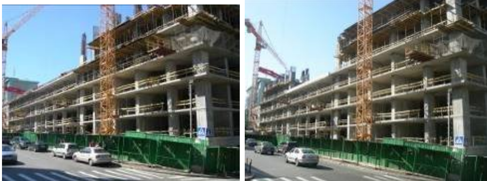
Будівельні роботи на об'єкті будівництва, обмеженого вулицями Предславинською, Ульянович та Червоноармійською станом на 04.06.2009 р. та на 21.08.2009 р.
