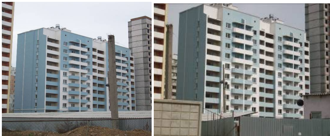
Рисунок 5. Житловий будинок № 285 у мікрорайоні III-4-2 Котовського у м. Одесі
