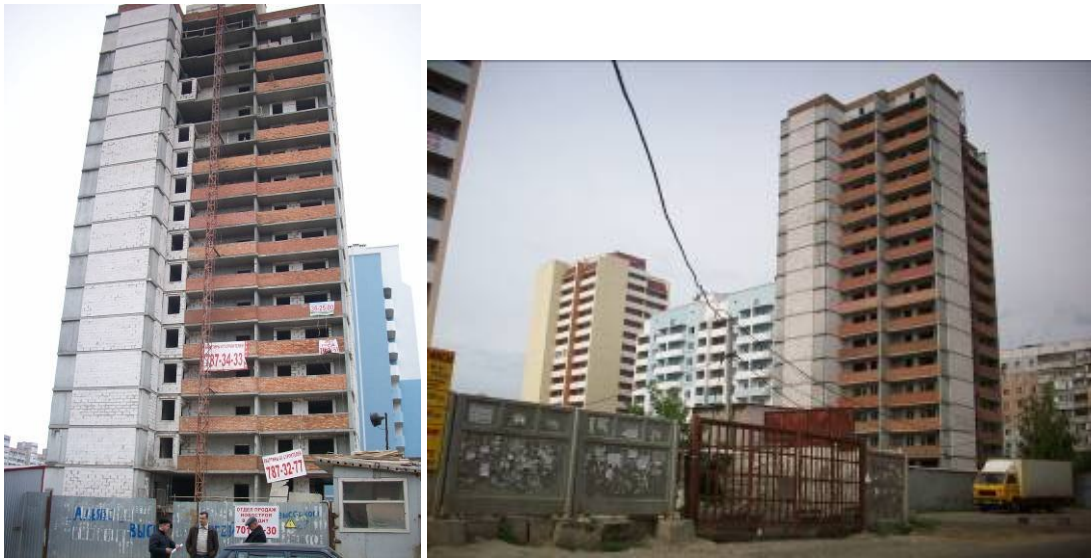
Рисунок 3. Стан будівельної готовності житлового будинку № 27 у мікрорайоні III-4-2 Котовського у м. Одесі станом на вересень 2009 р.
