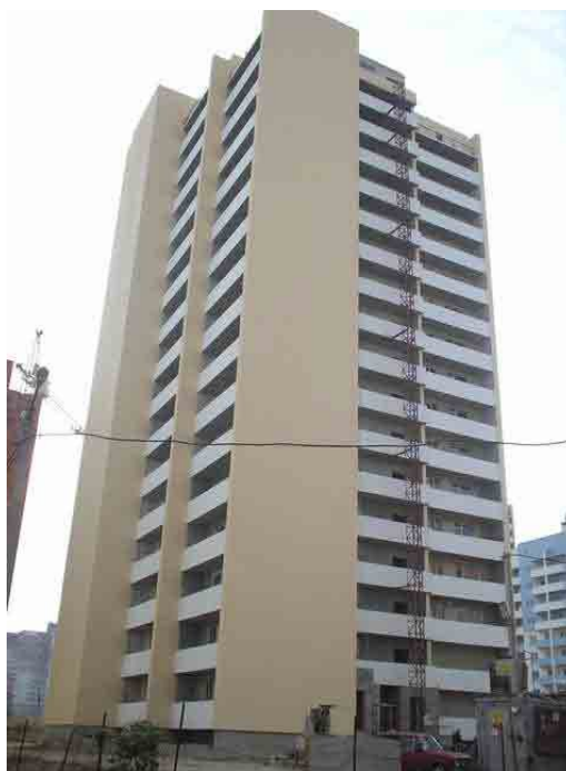
Рисунок 6. Житловий будинок № 29 у мікрорайоні III-4-2 Котовського у м. Одесі
