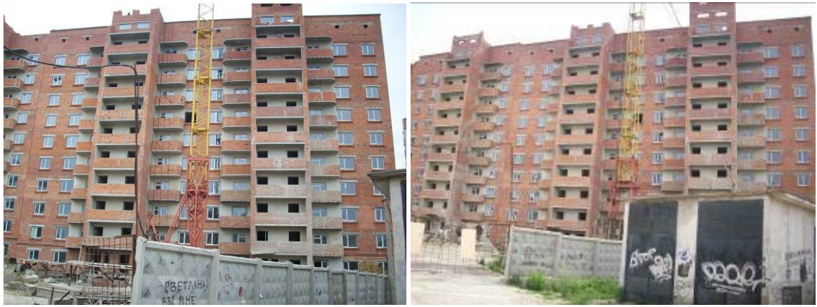
Рисунок 1. Стан будівельної готовності житлового будинку № 18 у мікрорайоні III-4-2 Котовського у м. Одесі станом на вересень 2009 р.
