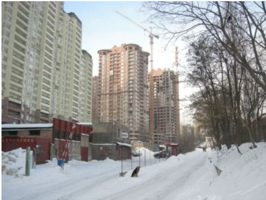
Рисунок 1. Будівельні роботи на об'єкті будівництва житлового комплексу по вул. Механізаторів, 2 (ж/к «Ізумрудний») у Солом'янському районі м. Києва станом на березень 2010 р.
