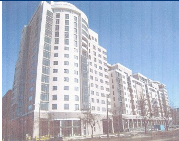
Об'єкт будівництва по пров. Банному в м. Харкові
