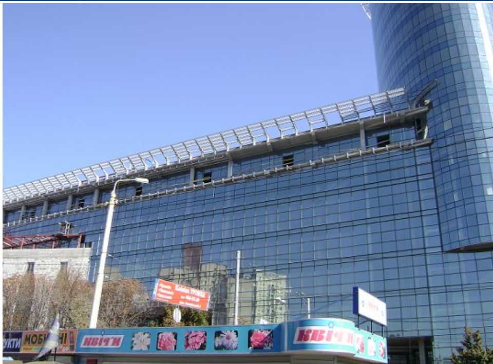
Хід робіт на об'єкті будівництва по вул. Мельникова, 2/10, станом на 01.12.2009 р.
