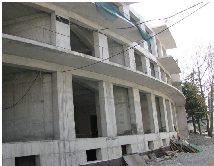
Хід робіт на об'єкті будівництва по вул. Ігнатенко, 9 у м. Ялті станом на початок травня 2010 року
