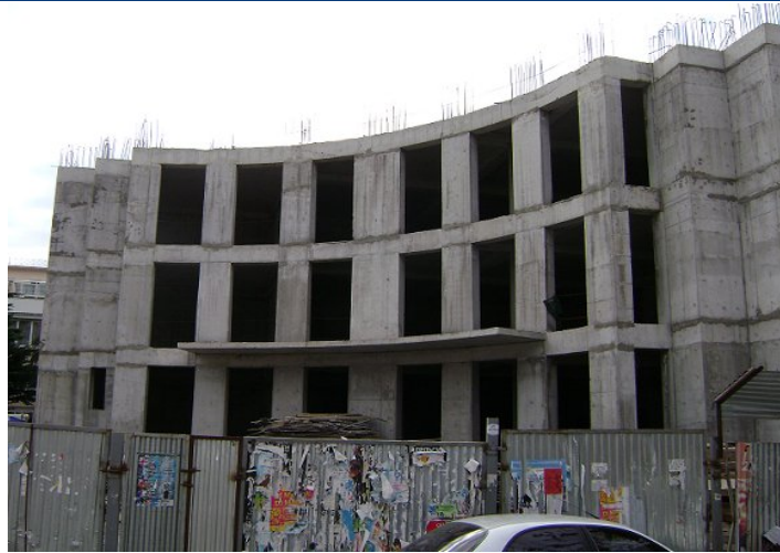
Хід робіт на об'єкті будівництва по вул. Ігнатенко, 9 у м. Ялті станом на 04.03.2010 р.
