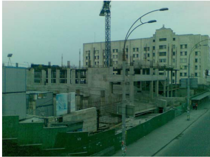
Рисунок 1.1. Стан будівництва офісної будівлі за адресою: м. Київ, пров. Індустріальний, 1-А на початок червня 2011 року.
