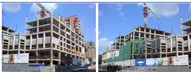
Будівництво багатофункціонального комплексу по вул. Виконкомівській, 1 станом на 10.07.2011 р.
