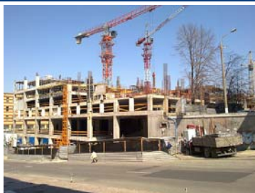
Будівництво багатофункціонального комплексу по вул. Виконкомівській, 1 станом на 23.04.2011 р.
