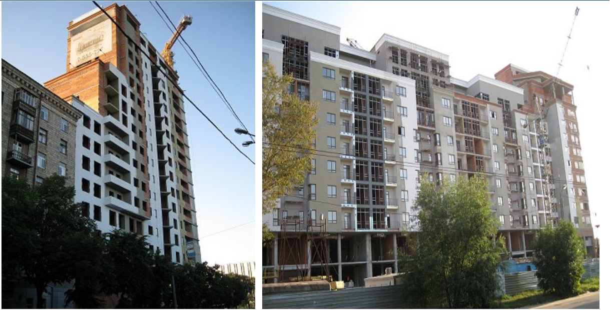
Хід робіт на об'єкті будівництва по пров. Банному в м. Харкові станом на 21.08.2009 р.
