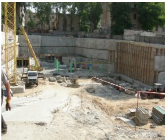
Хід робіт з будівництва багатоповерхового житлового по вул. Білоруській, 36-а у Шевченківському районі м. Києва станом на (зліва - направо) початок березня 2008 року та початок червня 2008 року
